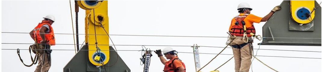
Figura 08: Sistema de Ancoragem.
